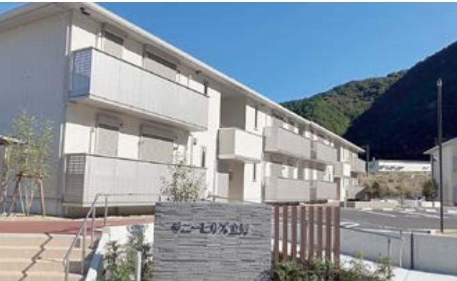
▲サニーヒルズ立野の外観
