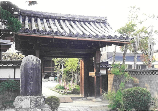
安土城唯一の遺構：超光寺表門（東近江市）
