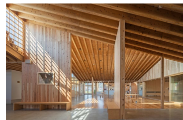
↑ 地域材を活用した建築物
