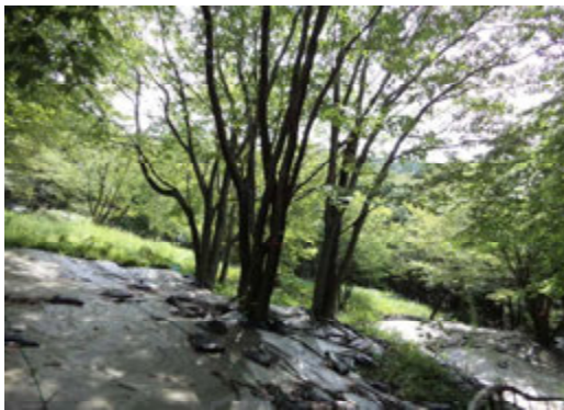
遺構に損傷を与える恐れのある樹木
