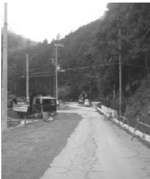
多賀醒ヶ井線の道路改修
