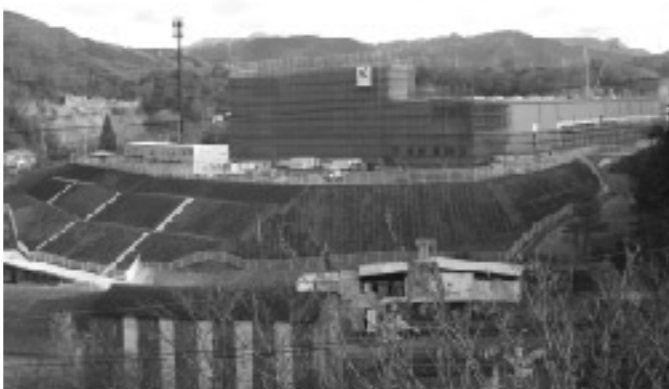
着々と進む工場建設(多賀第2工業団地)
