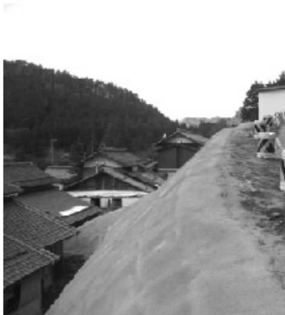
萱原地先の急傾斜工事
