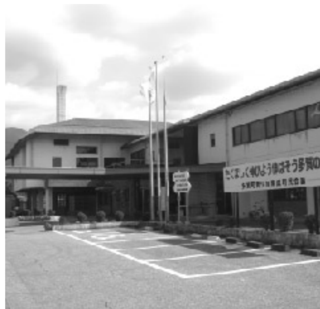
老朽化した中央公民館
