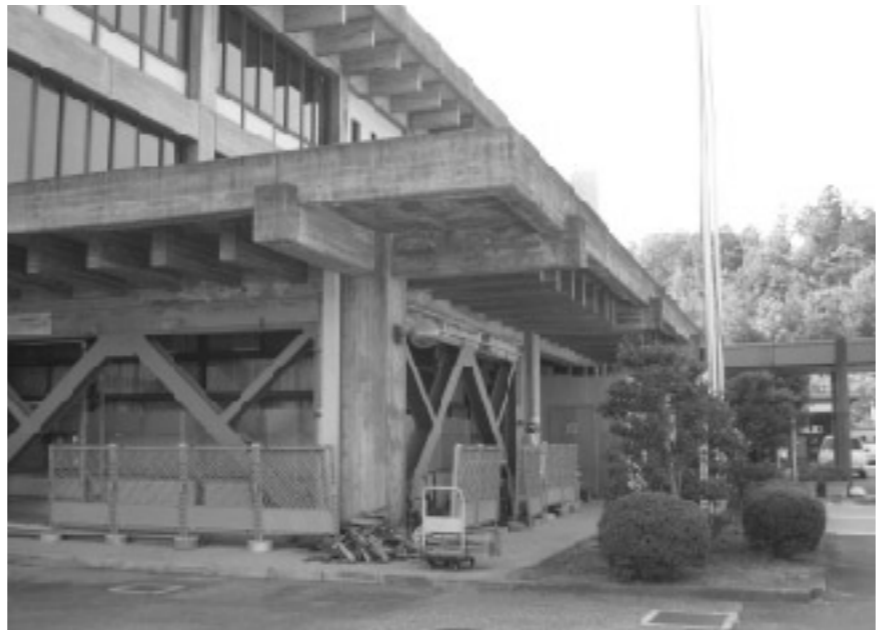
着々と整備が進む 庁舎耐震工事
