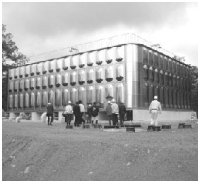
大谷第2配水池
