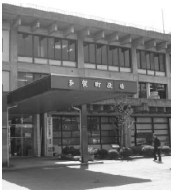
耐震工事が待たれる庁舎
