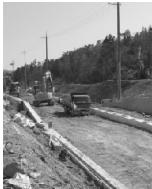
第2工業団地進入路新設工事
