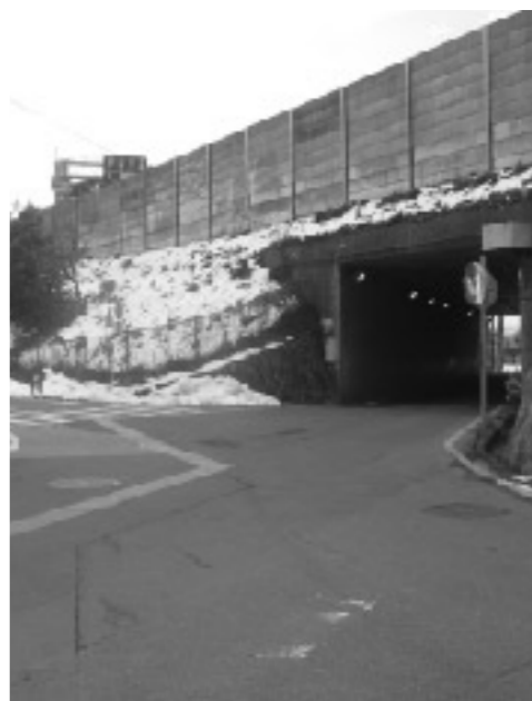
四ッ屋 名神高架歩道
