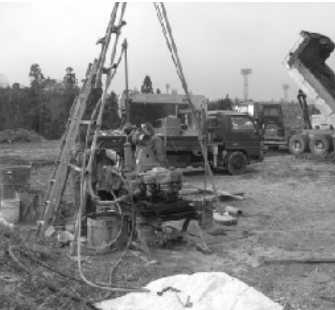
第2工業団地ボーリング調査
