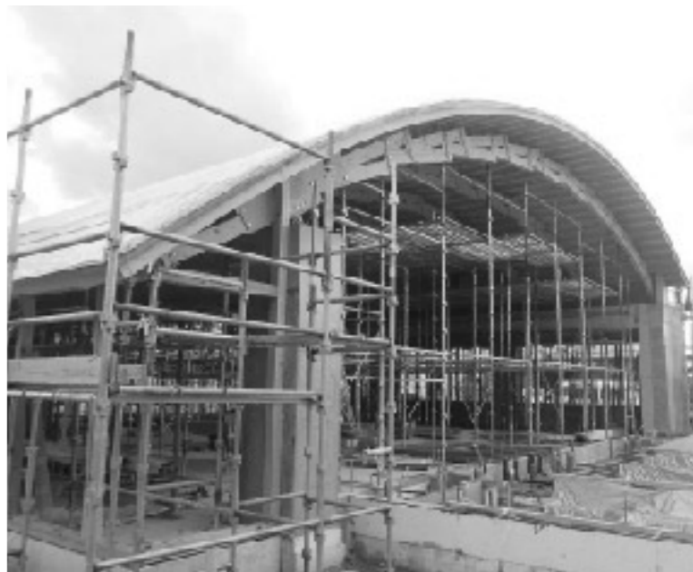
建設中のランチルーム
