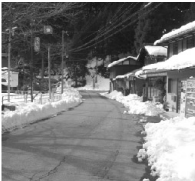
着工が待たれる道路整備
