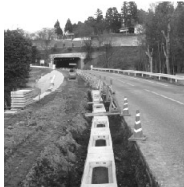
敏満寺地内の歩道工事
