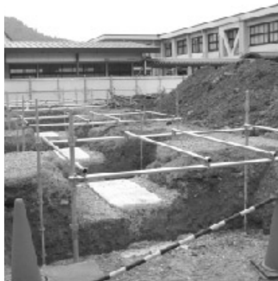
中学校ランチルーム建設工事
