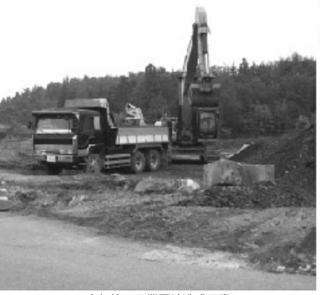
多賀第2工業団地造成工事
