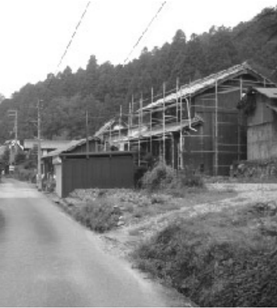
水谷地区家屋改修
