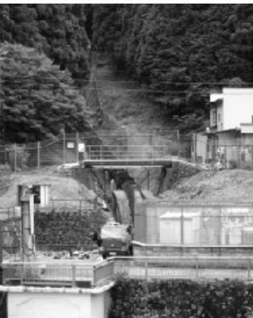
犬上ダム水力発電所
