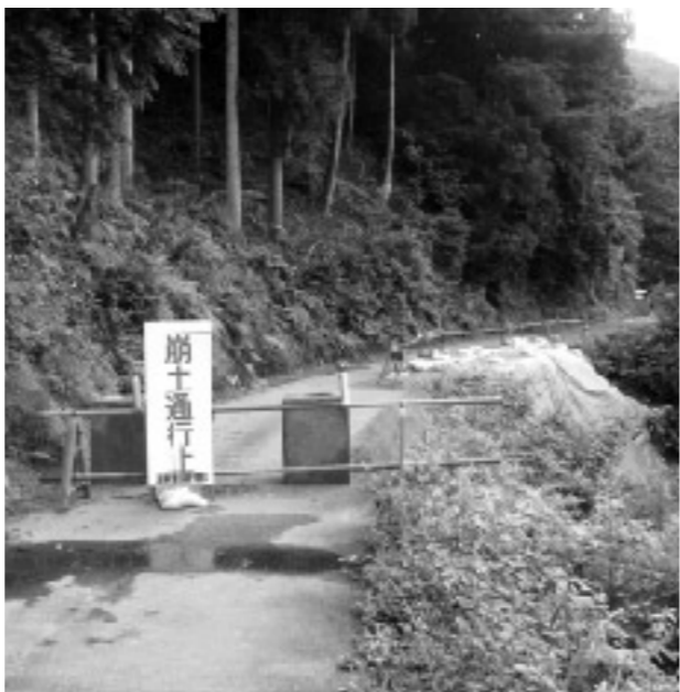
県道多賀永源寺線崩落現場
