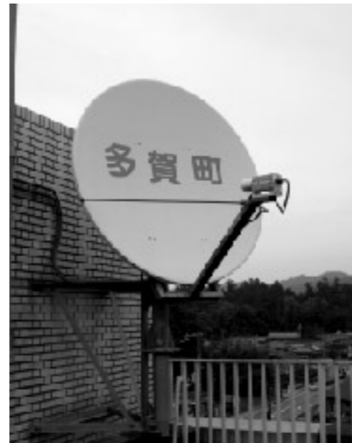
全国瞬時警報システム(衛星アンテナ)
