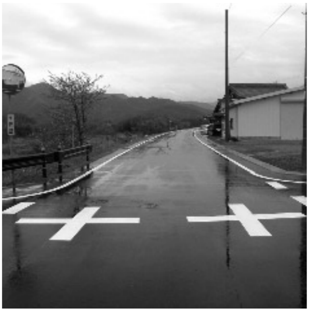
久徳中川原線一部開通(中川原地先)
