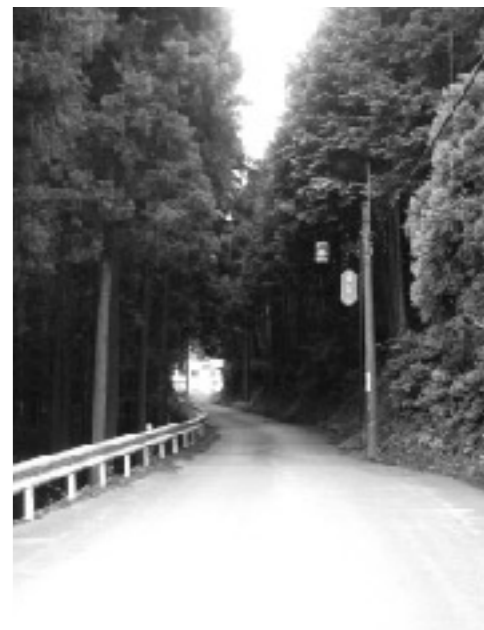
町道 尺仏川相線改良工事
