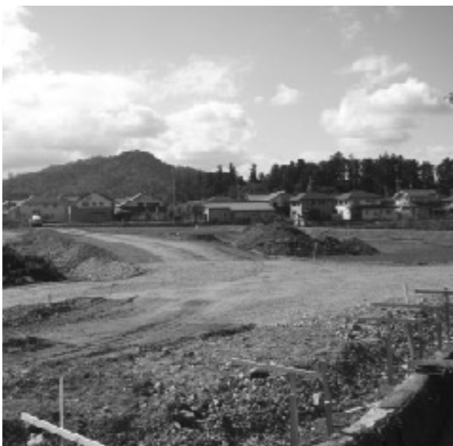
(仮称)グリーンヒル多賀の造成工事
