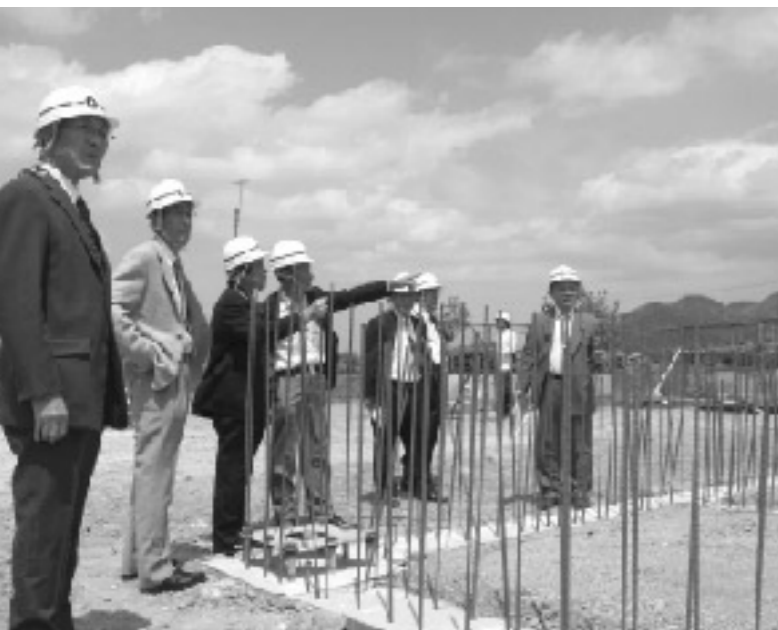
雪寒基地の基礎工事(大岡地先)
