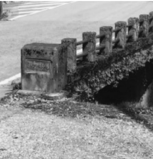
昭和38年に完成した霜ヶ原橋
