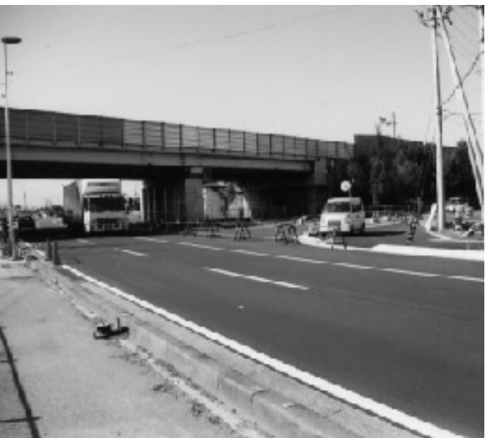
交差点の信号機基礎工事中
