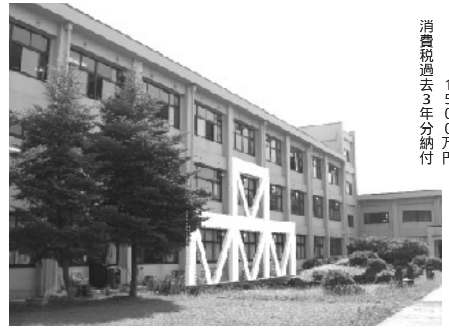
耐震補強工事がはじまる中学校
