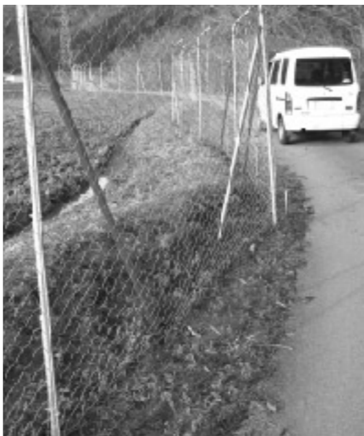
今後計画的に設置される獣害防止恒久電気柵
