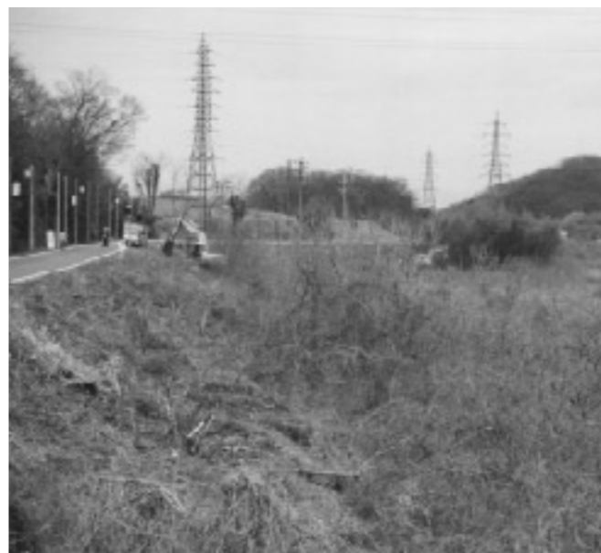
土田ブリヂストン裏の芹川河川で実施されている樹木伐採等除去作業
