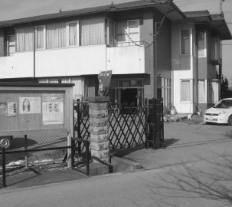
バリアフリー化される多賀福祉会館
