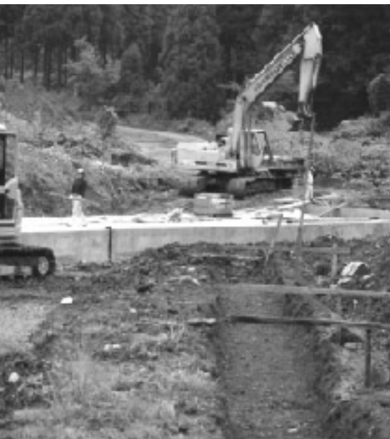
工事が進む小森池線
