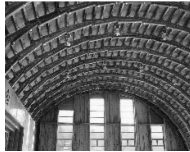
地元産杉材を用いた 大滝小学校屋内運動場
