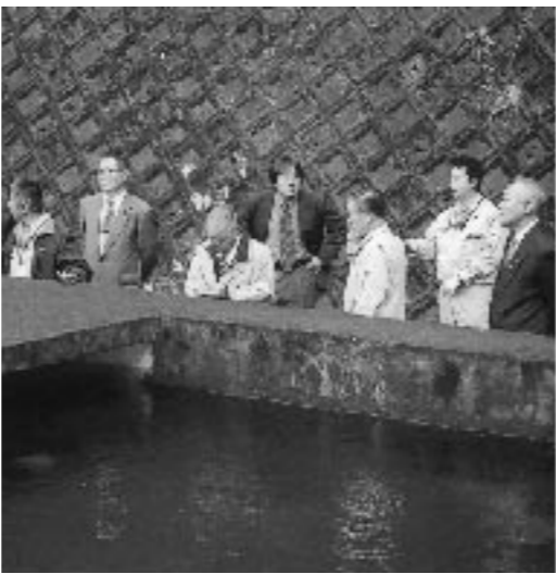
老朽化した上水道施設
