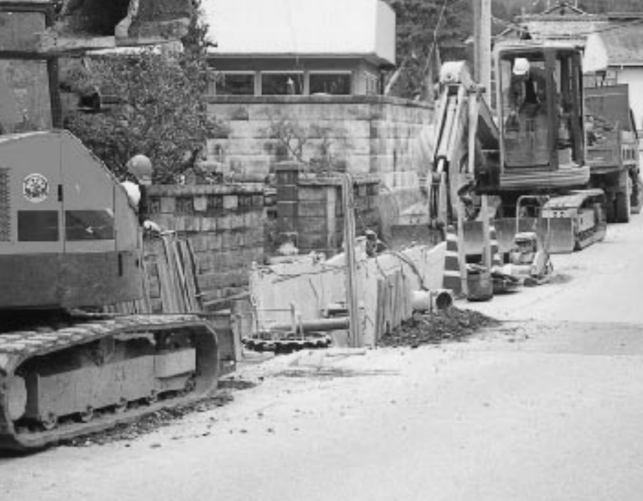
川相地先の下水道工事現場
