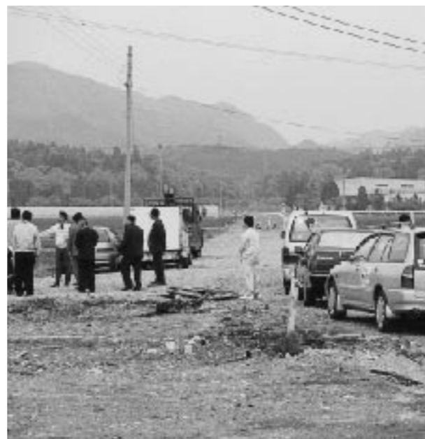
工事が進む町道小森池線
