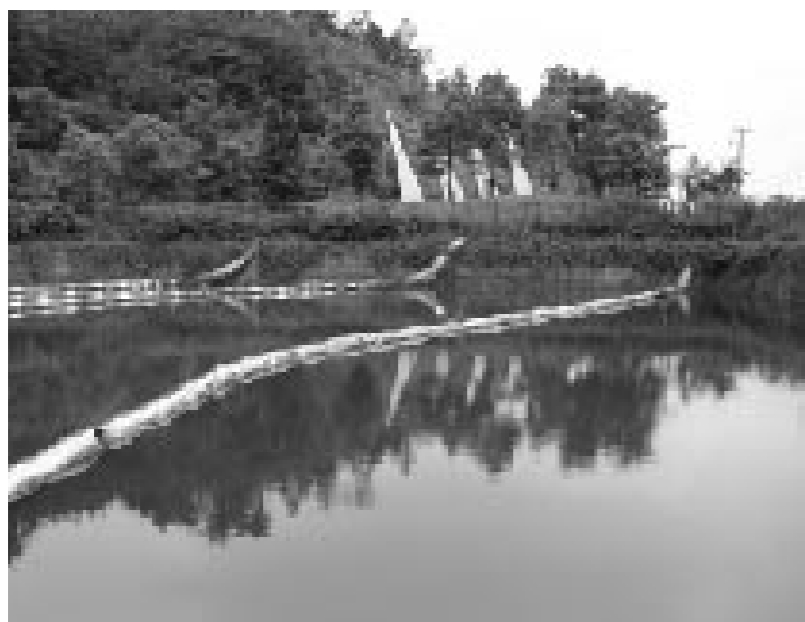
中核工業団地二号沈砂池 濁水防止
