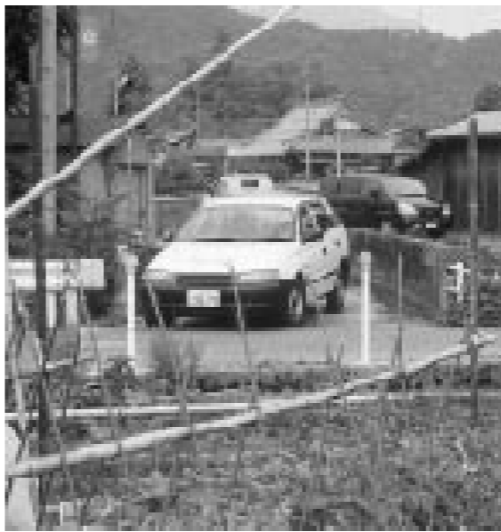
早期着工が望まれる町道久徳、中川原線拡幅工事
