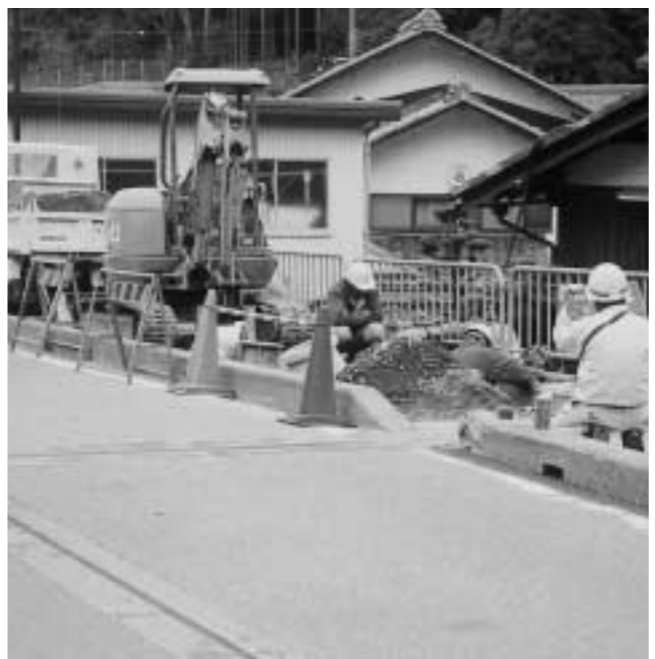
佐目地区の農業集落排水工事
