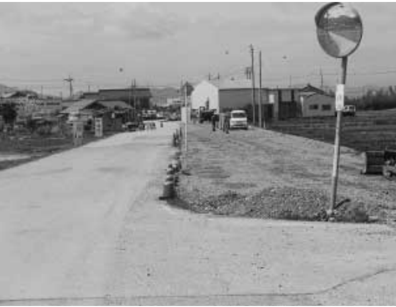
工事が進む町道小森池線
