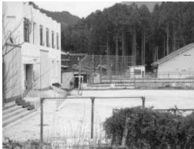
大滝小プール撤去跡地に建設予定の屋内運動場
