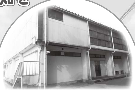
小学校補修工事など (多賀小学校体育館) 2220万円
