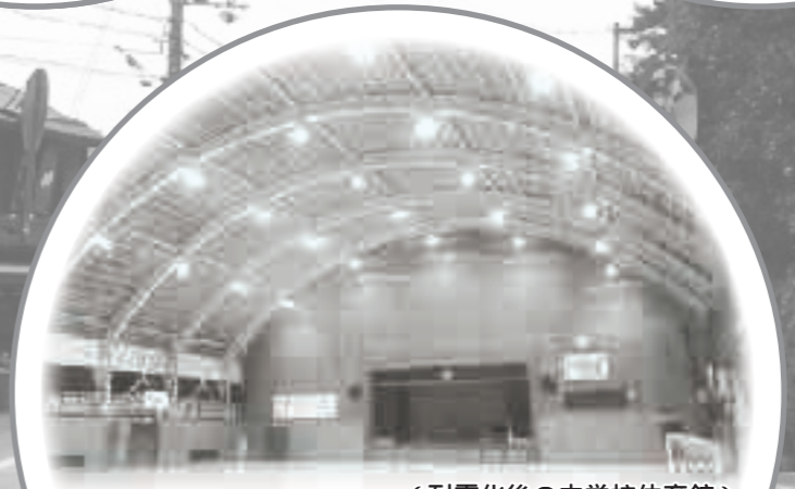
(耐震化後の中学校体育館)
