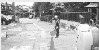
絵馬通り改修工事はじまる
