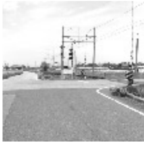
7号踏切(多賀・土地先)
