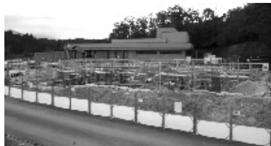
基礎工事中の紫雲苑
