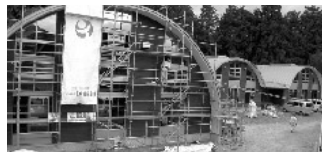
高取山ふれあい公園自然体験宿泊施設 工事現場
