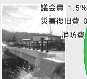
四手川橋架設工事 (月之木地先)
