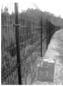
中学校獣害対策用フェンス
