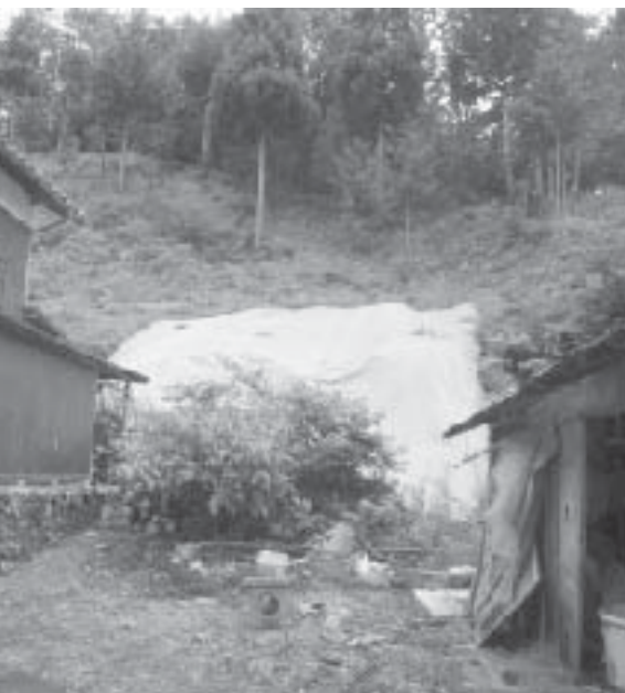
八重練地区(急傾斜)工事
