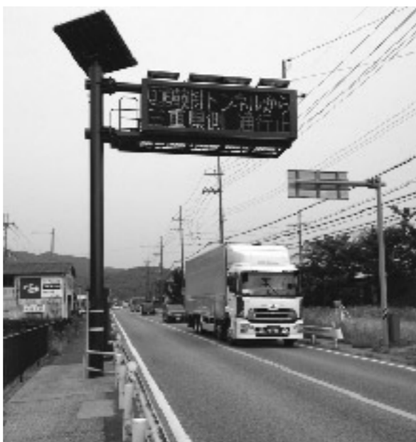
通行止めが続く鞍掛峠
