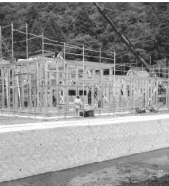
建設中の下水谷集会所
