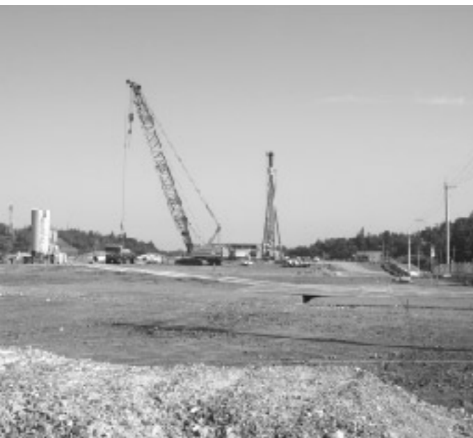
多賀第2工業団地フジパン建設工事
