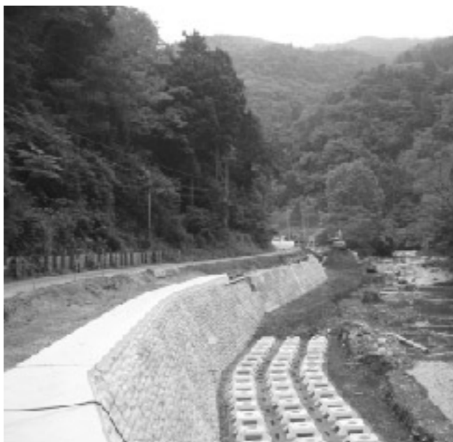
芹谷地域道路拡幅工事
