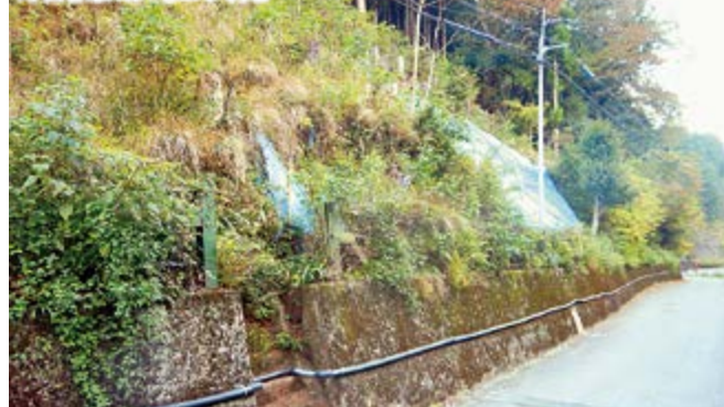
南後谷急傾斜地工事現場
