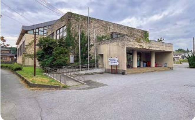
老朽化が進む勤労者体育センター
