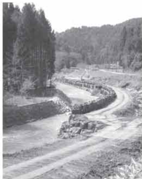
県道多賀・醒ヶ井線道路改良工事
