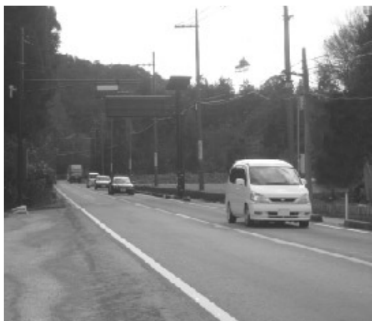
国道307号 急勾配の解消を一刻も早く
