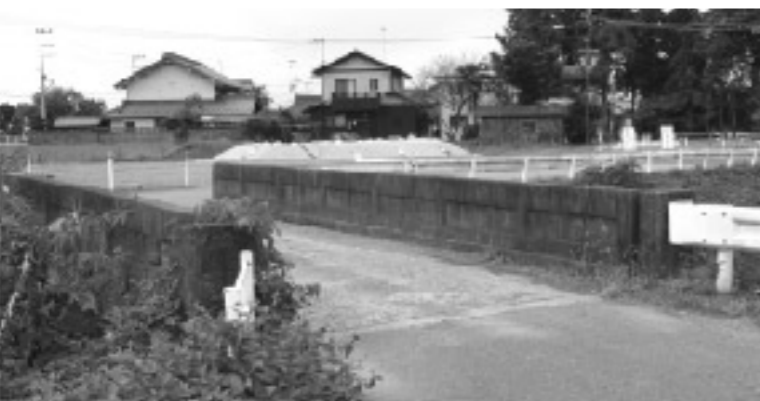
四手川橋橋梁架設工事 月之木地先
