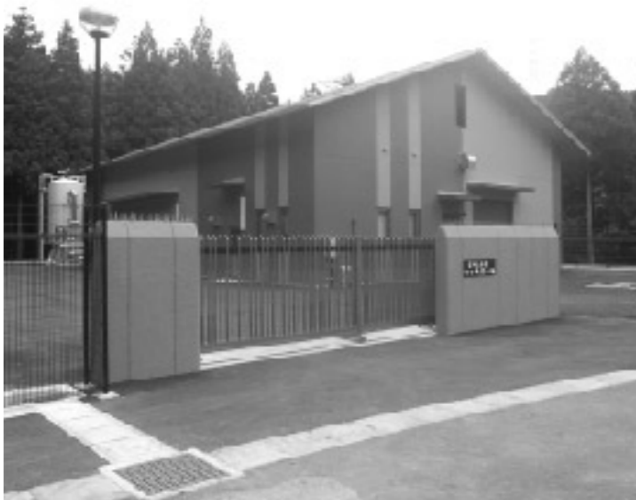
8月23日竣工 仏ヶ後浄水場
