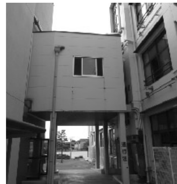
多賀小学校北校舎
