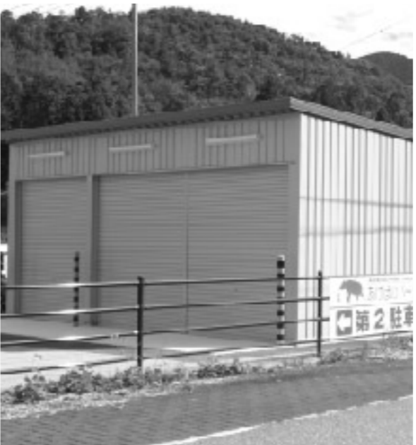
防災備蓄倉庫 四手地先
