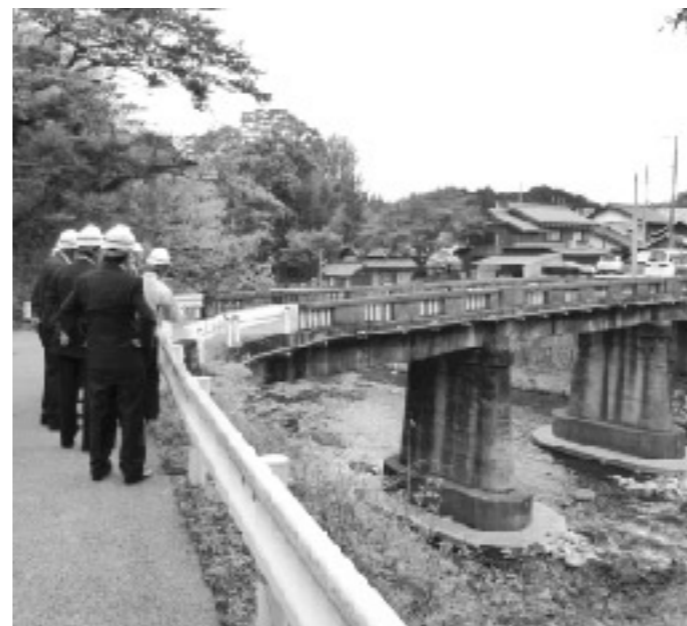
一ノ瀬橋視察(橋梁長寿命化)
