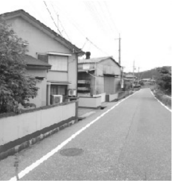
県道佐目敏満寺線の側溝(富之尾地先)
