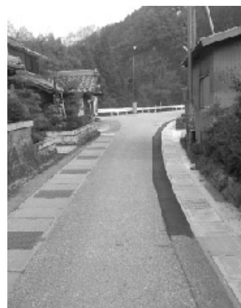
萱原区内で完了した側溝ふた
