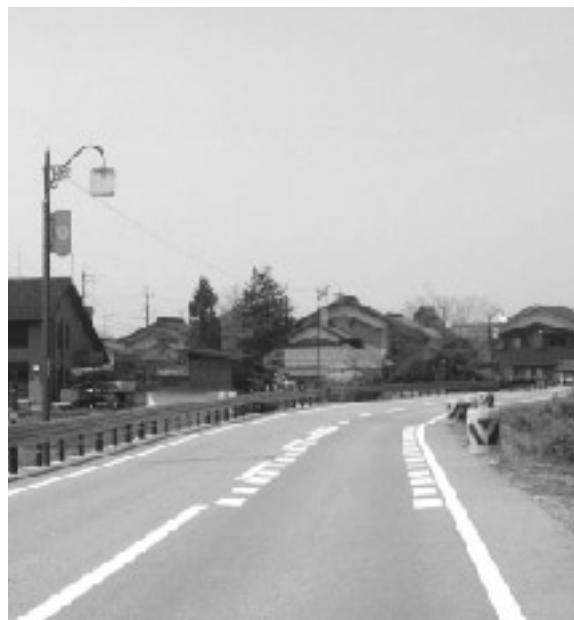
LEDが取り付けられた防犯灯
