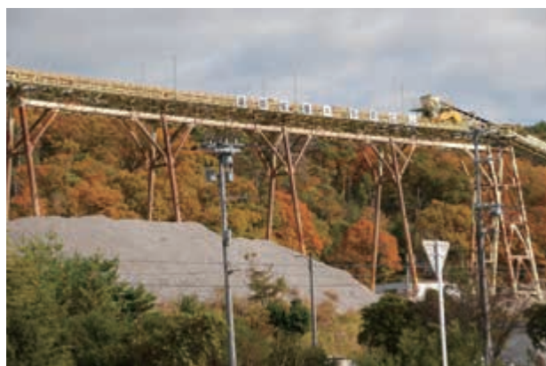
◆多賀鉱山から搬出された石灰岩の貯蔵所
