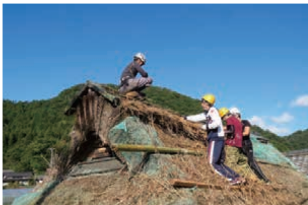
◆葺の葺き替え（栗栖地区）
