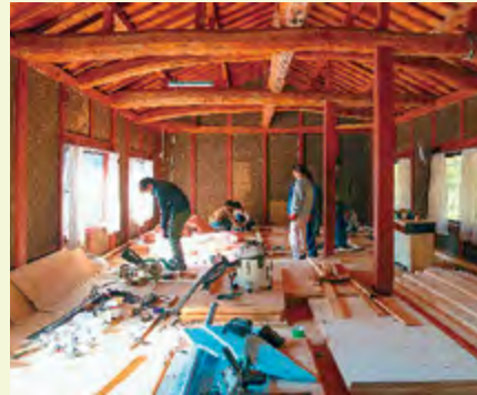
▲樋田地区の空き家改修
