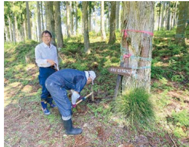
▲下山案内看板の設置
