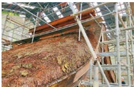
▲修理前の状況
