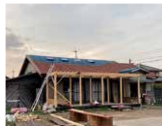
▲屋根工事のようす
