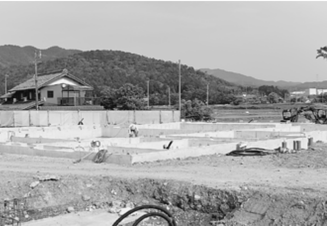
▲ホール棟の基礎工事も進んでいます
