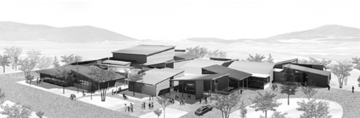
▲建築概要 構造:木造平屋建て 延床面積:2611.84㎡
