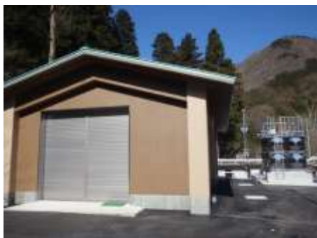
新設した大君ヶ畑浄水場
