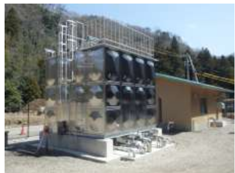
新設した水谷加圧所
