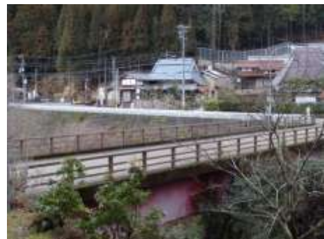
長寿命化工事を施工する鎮守橋（萱原地先）
