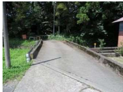
長寿命化工事を施工する不動橋（多賀地先）
