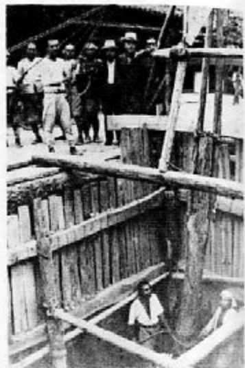
① 大鳥居南側石柱基礎工事
