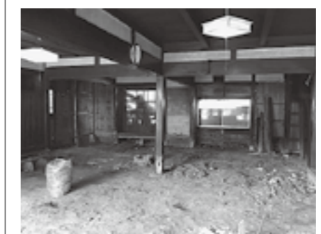
▲川相区のお試し住宅の工事の様子
