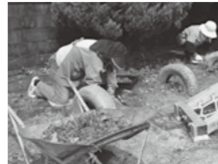
▲きれいになっていく遊具周辺
