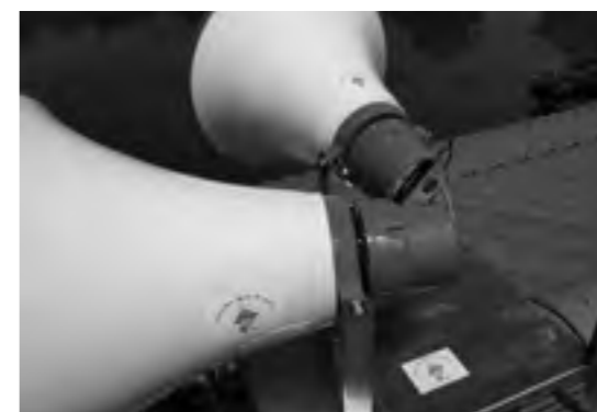
▲地域行事の周知や緊急時に役立つ屋外放送設備
