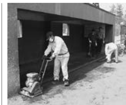
▲整備作業のようす
