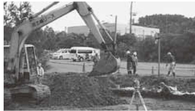
▲写真1 発掘現場:滋賀産産敷地内(四手)
