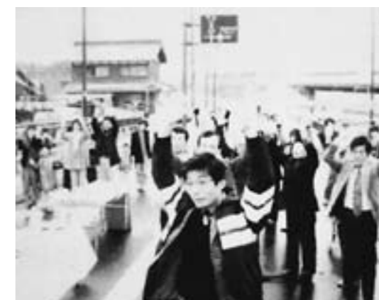
▲中川原橋竣工渡り初め式
