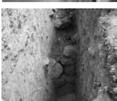
作業風景(写真上)
