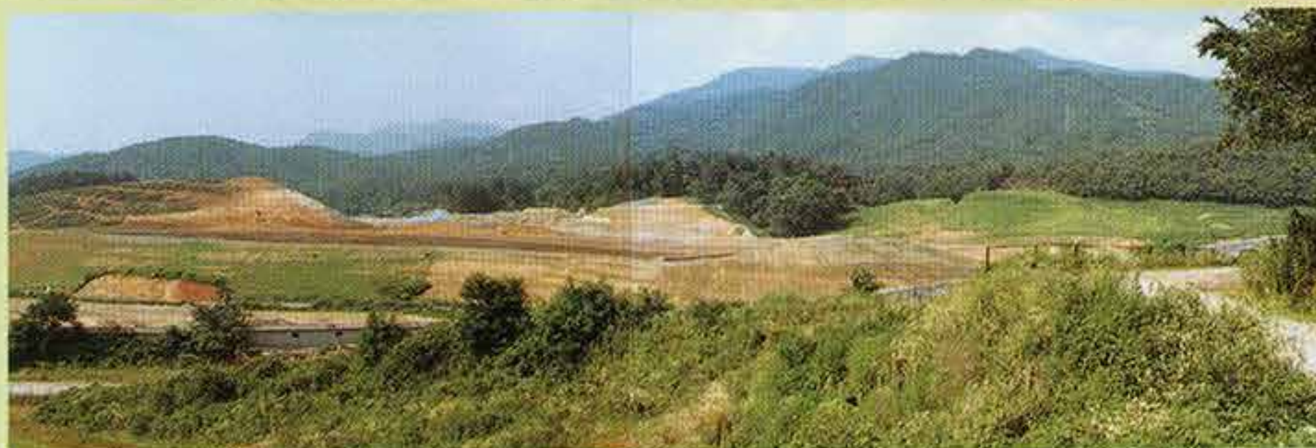
◀ 第2期の造成工事がほぼ完成した四手の丘陵
